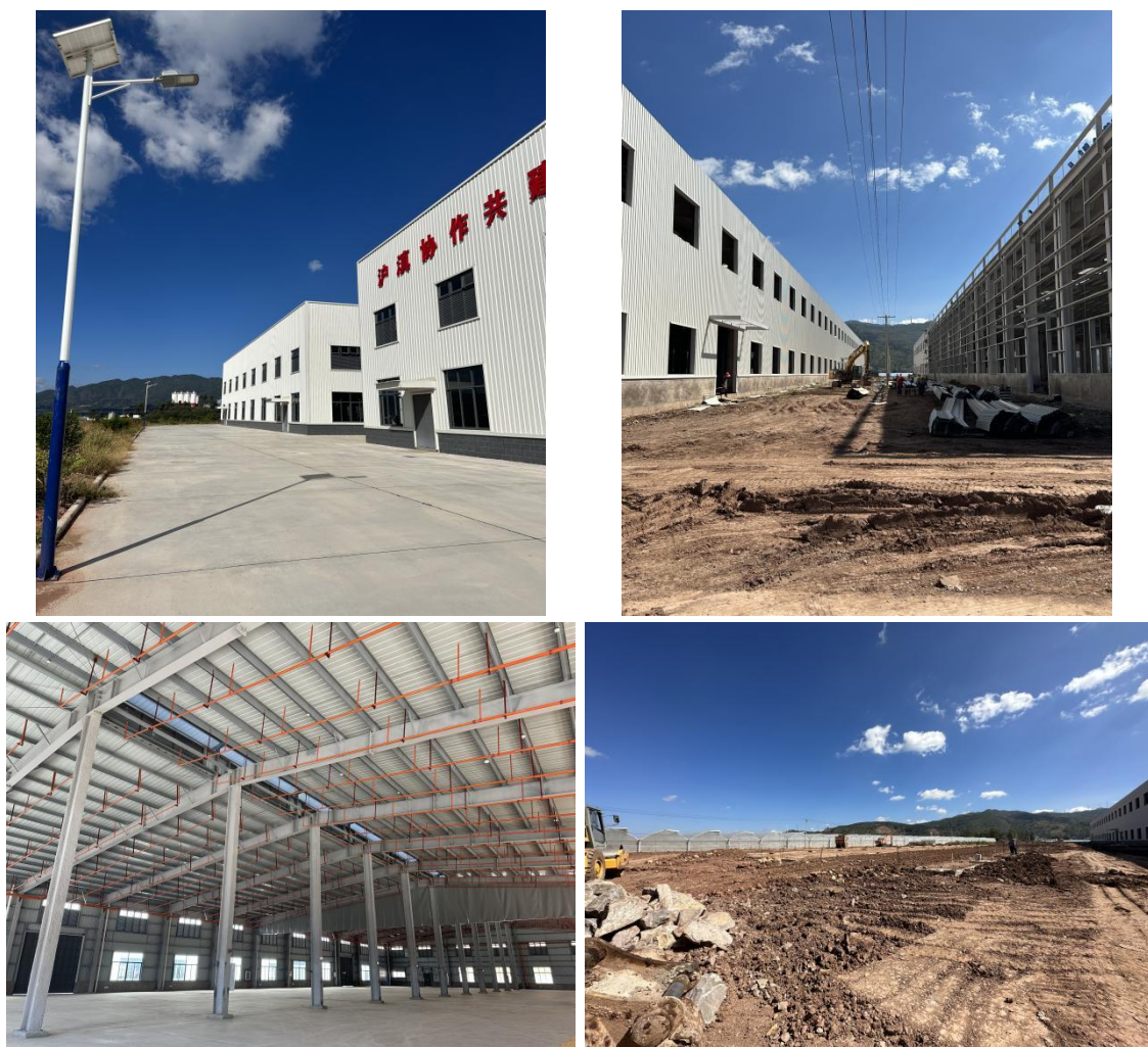
图 1 一期项目厂房
